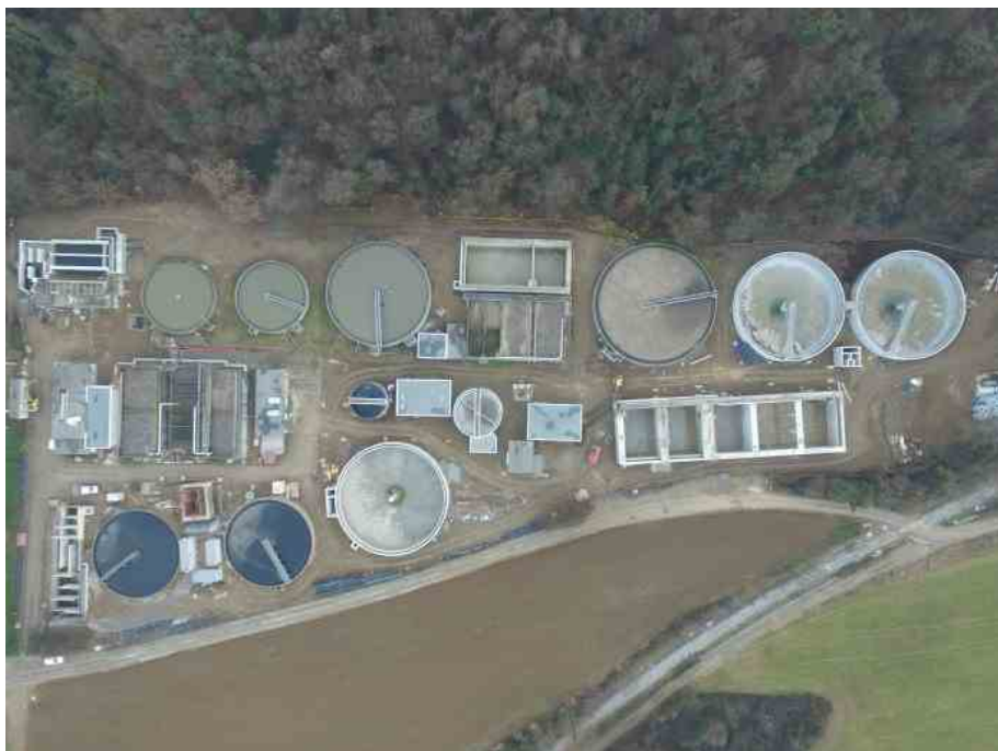
Il depuratore di Paratico oggi
