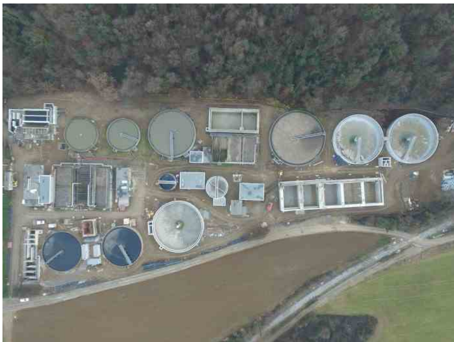
Il depuratore di Paratico oggi
