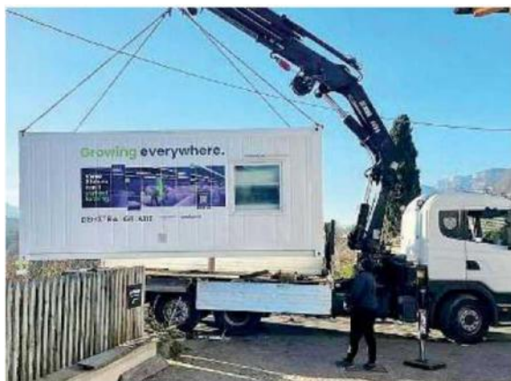
Demetra. Il container ricondizionato dalla Greatit
